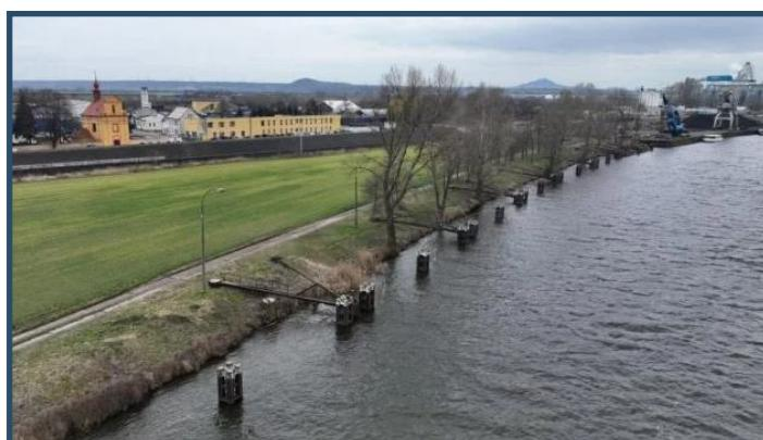
Vrchní patro bude umístěno 1,8 m nad kritickou hladinu. Následující podesty budou odstupňovány po výškách 1,3 m. Ocelový žebřík o délce 9,2 m bude veden po straně konstrukce, odvrácené od směru proudění. Prostřední dalba bude osazena ocelovou přístupovou lávkou spojující ji se břehem. Stavební náklady ve výši 17,8 mil. Kč bez DPH financuje Státní fond dopravní infrastruktury. Zhodnotitelem je Labská strojní a stavební s.r.o.
